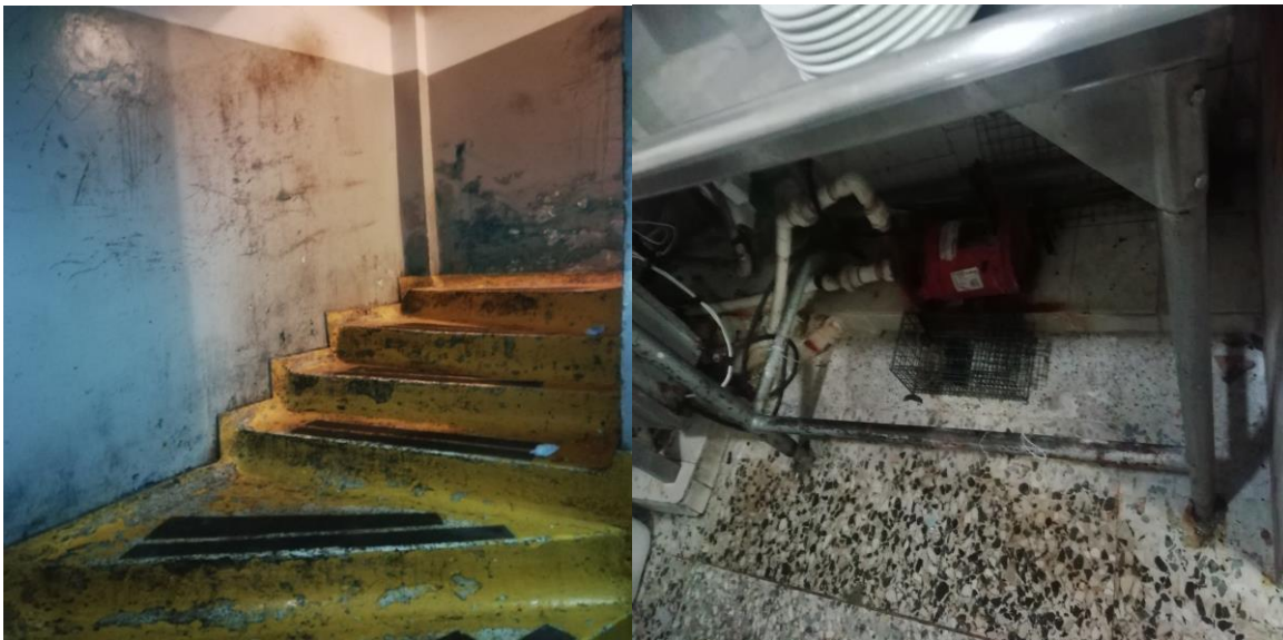
Escaleras con dirección almacén materias primas
