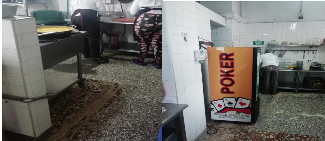
Piso de la Cocina
