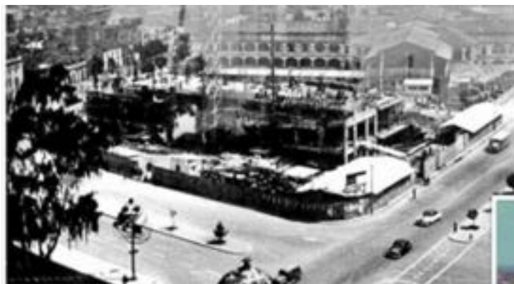
Foto, Construcción Hotel Tequendama
