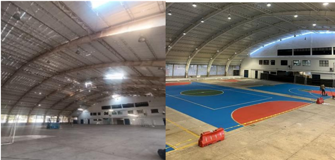
Ilustración 25. Proyecto Cubierta Coliseo Armada Nacional (Antes - Después)
