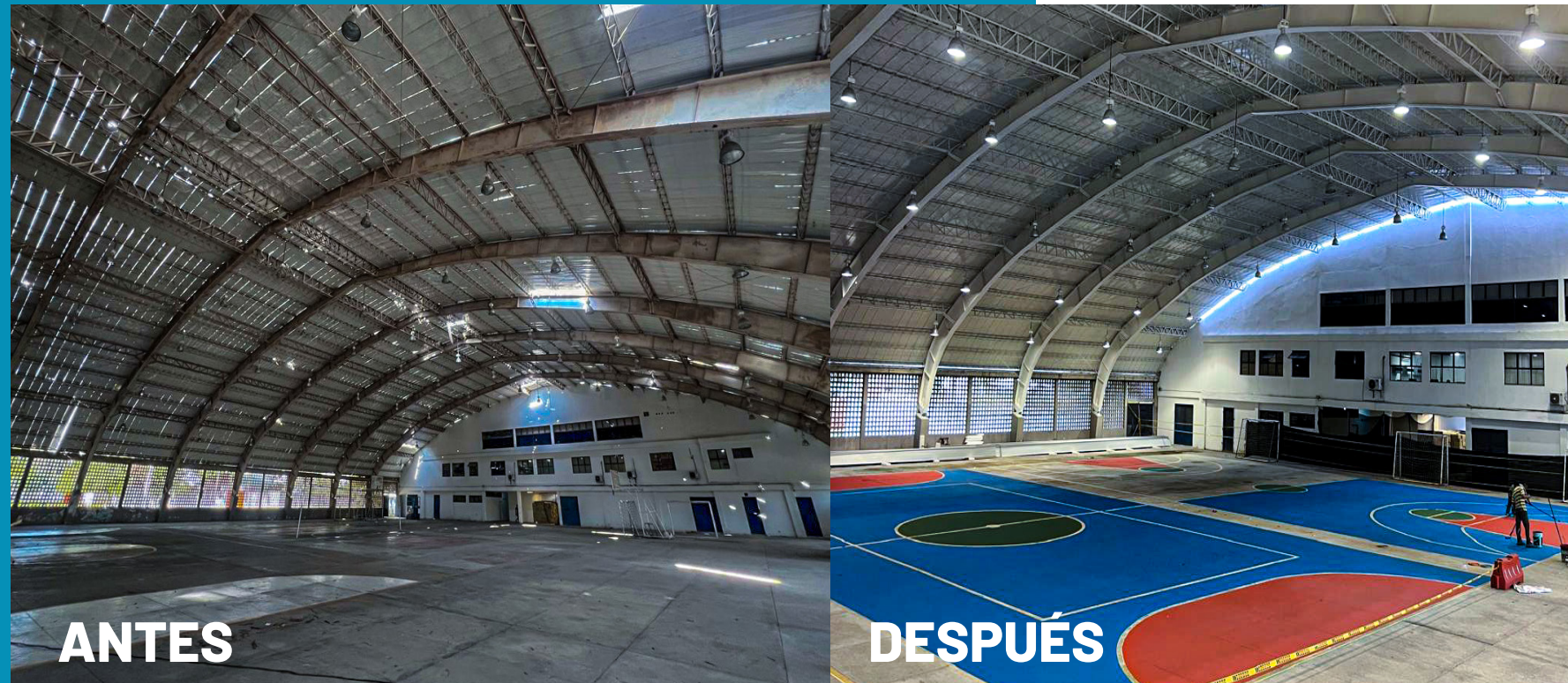
Ilustración 25. Proyecto Cubierta Coliseo Armada Nacional (Antes - Después)
