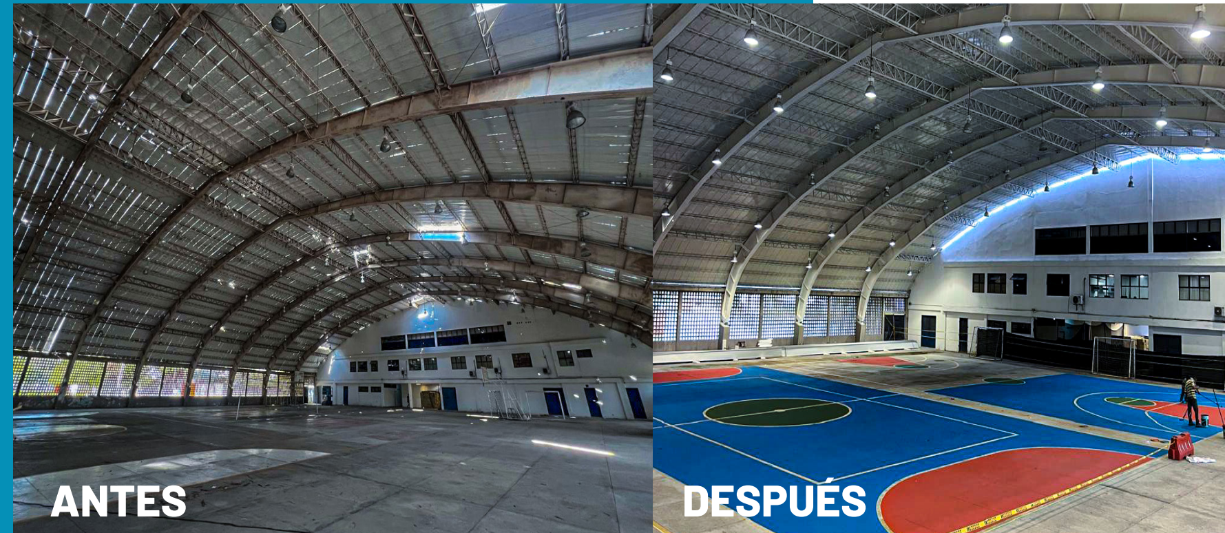
Ilustración 25. Proyecto Cubierta Coliseo Armada Nacional (Antes - Después)
