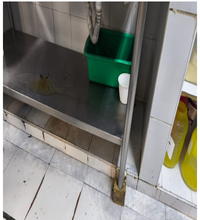
Imagen 24. Pata de mesón con soporte de madera para nivelar.
