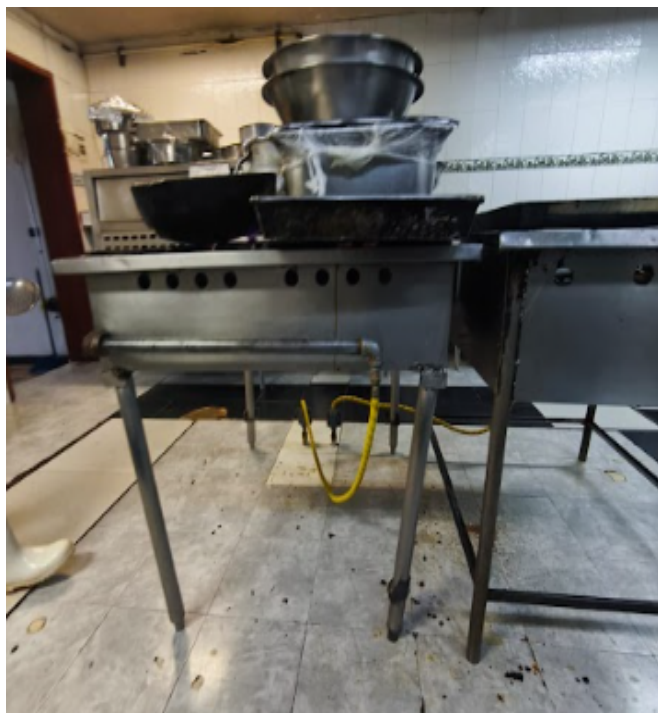
Imagen 27. Estufa a gas con pata doblada.
