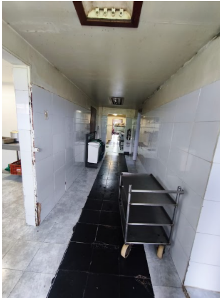
Imagen 1. Pasillo Conexión Cocina y Puerta Trasera (Transporte alimentos)
