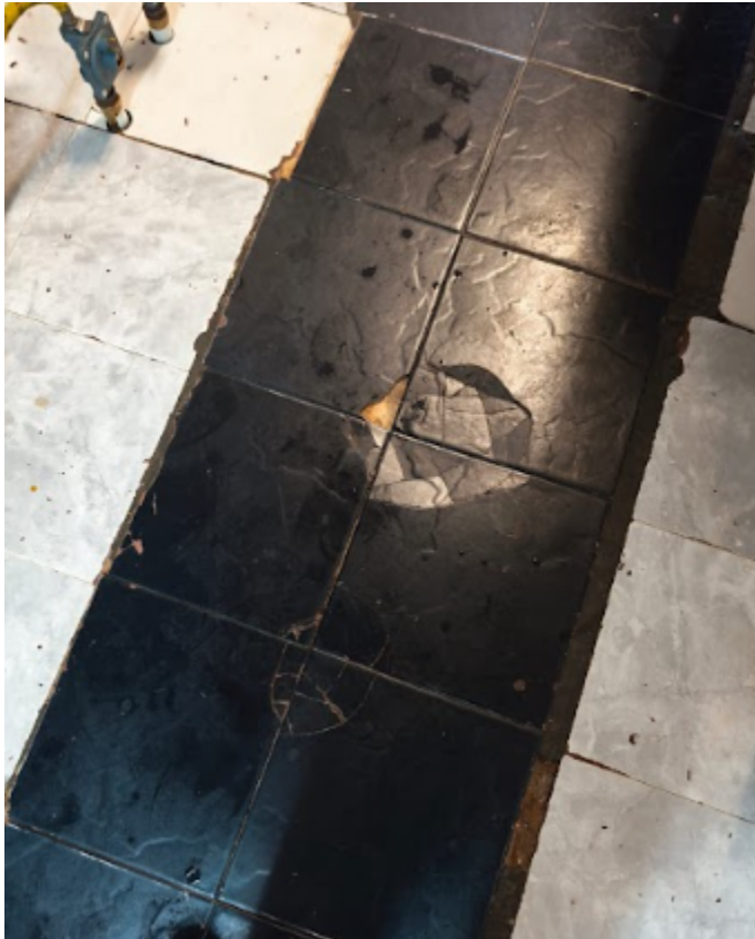
Imagen 3. Piso de cocina con baldosa fisurada y sumida. Imagen 4. Piso de cocina con baldosa rota y sumida.
