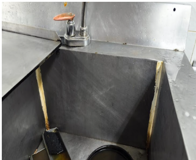
Imagen 25. Borde de lavaplatos con sellante plástico.
