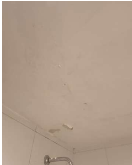
Imagen 6. Humedad en el techo de la ducha.
