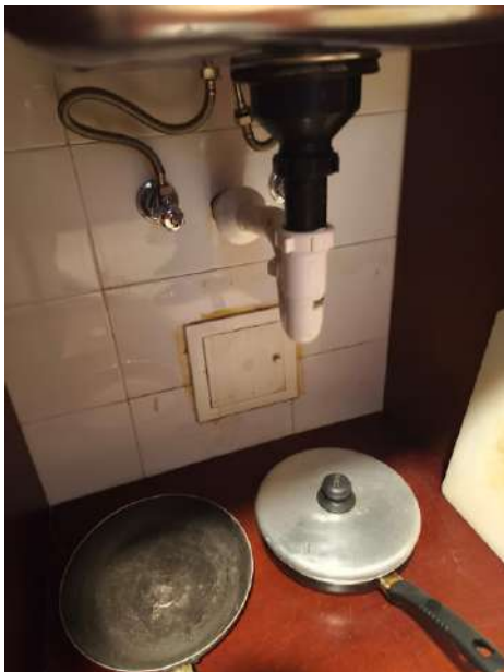
Imagen 4. Arreglo fuga lavaplatos.
